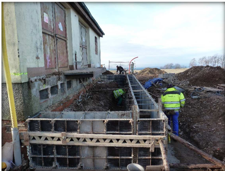
Výstavba informačního centra u rozhledny
