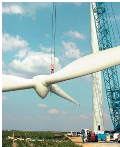
V Pávově nedaleko Dlouhé Brtnice byly letos v červenci vztyčeny dvě větrné elektrárny VESTAS V90-2,0 MW (na snímku záběr z jejich instalace). Také tam byla investorem společnost ELDACO.
