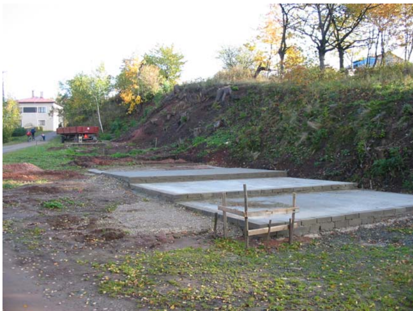
Základy pro garáže v Písníku
